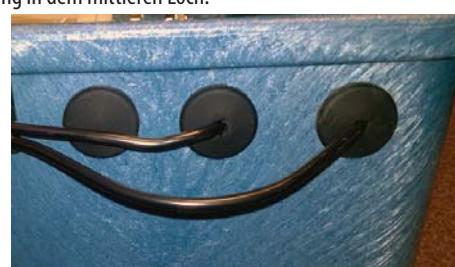
Führen Sie die Steckanschlüsse zusammen. Achten Sie darauf, dass die Pfeilsymbole sich gegenüber stehen. Als letzten Schritt schieben Sie den Schwimmer auf die gewünschte Position. Achten Sie darauf, dass der Schwimmer im aktiven Stand (Schwimmer treibt hoch) tiefer stehen muss als der oberste Rand des Schmutzablaufes. Steht der Schwimmer höher als der Schmutzablauf, wird das Wasser über diesen Ablauf strömen und abfließen.
